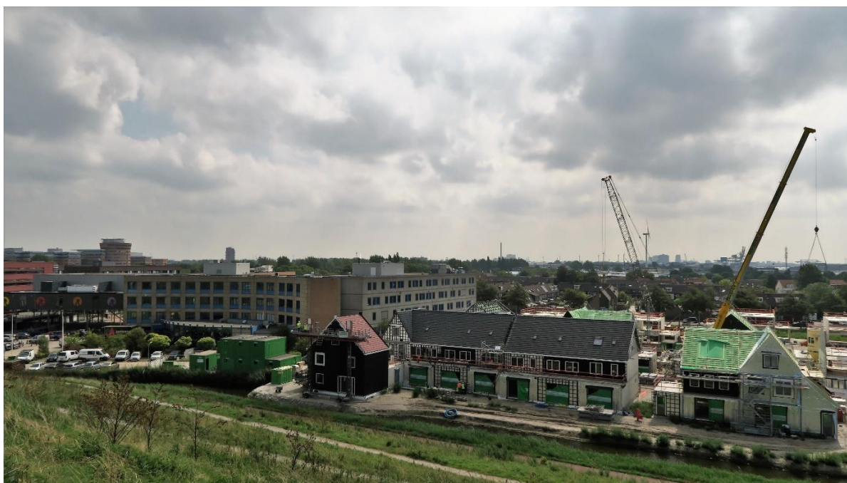
Foto 6: Groen Hout in aanbouw (sept 2018)
