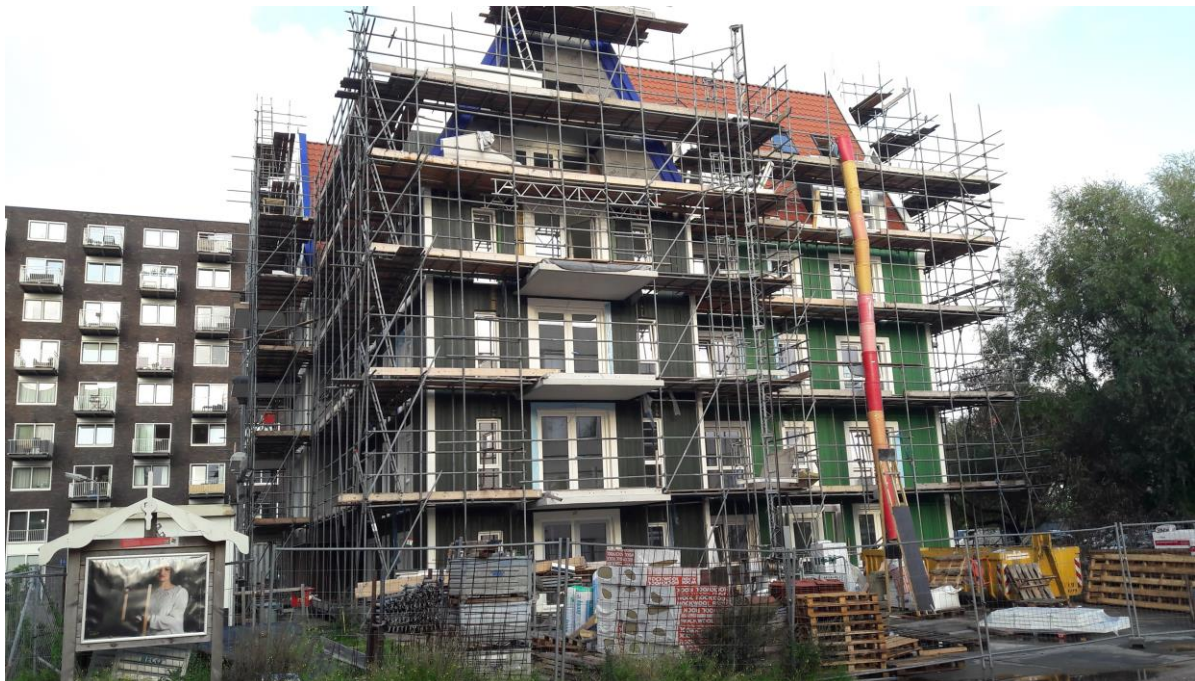
Foto 5: Fier Zaans in aanbouw (sept 2018)
