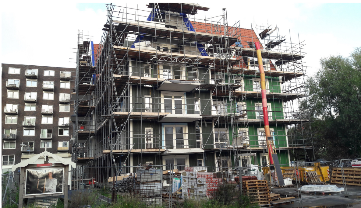
Foto 5: Fier Zaans in aanbouw (sept 2018)
