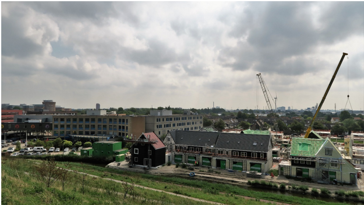
Foto 6: Groen Hout in aanbouw (sept 2018)
